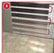
3 Systém stenového vykurovania
